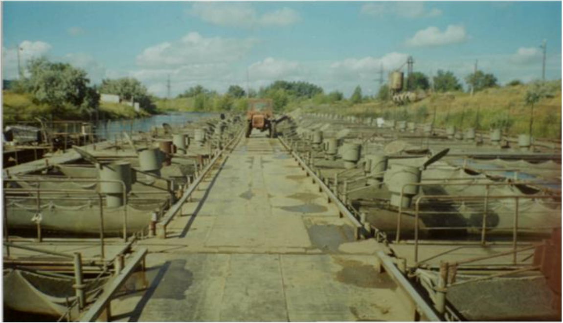
Рисунок 10 – Садковая линия в сбросном канале Ириклинской ГРЭС
